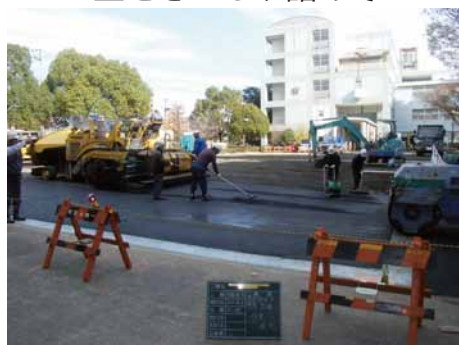
アスファルトを敷いて
